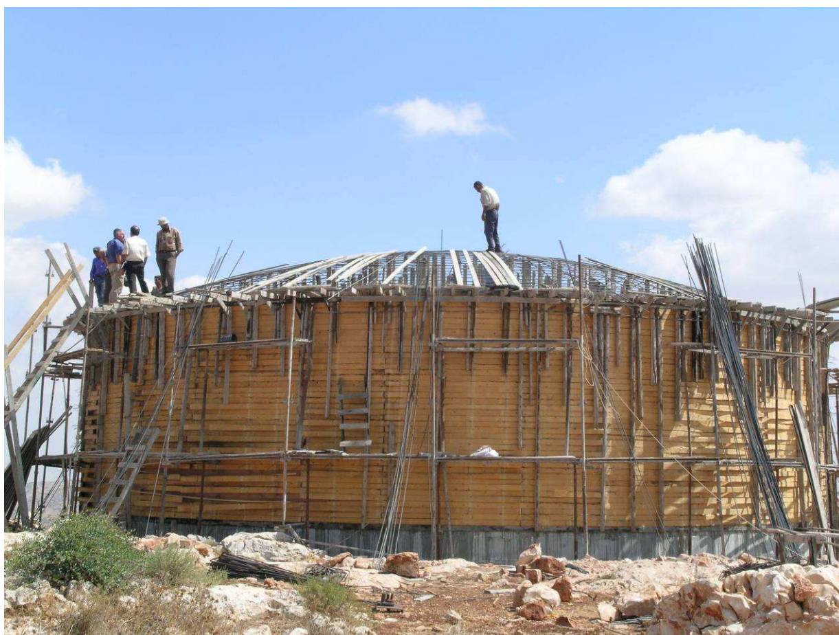
Palestine : construction d'un réservoir d'eau
