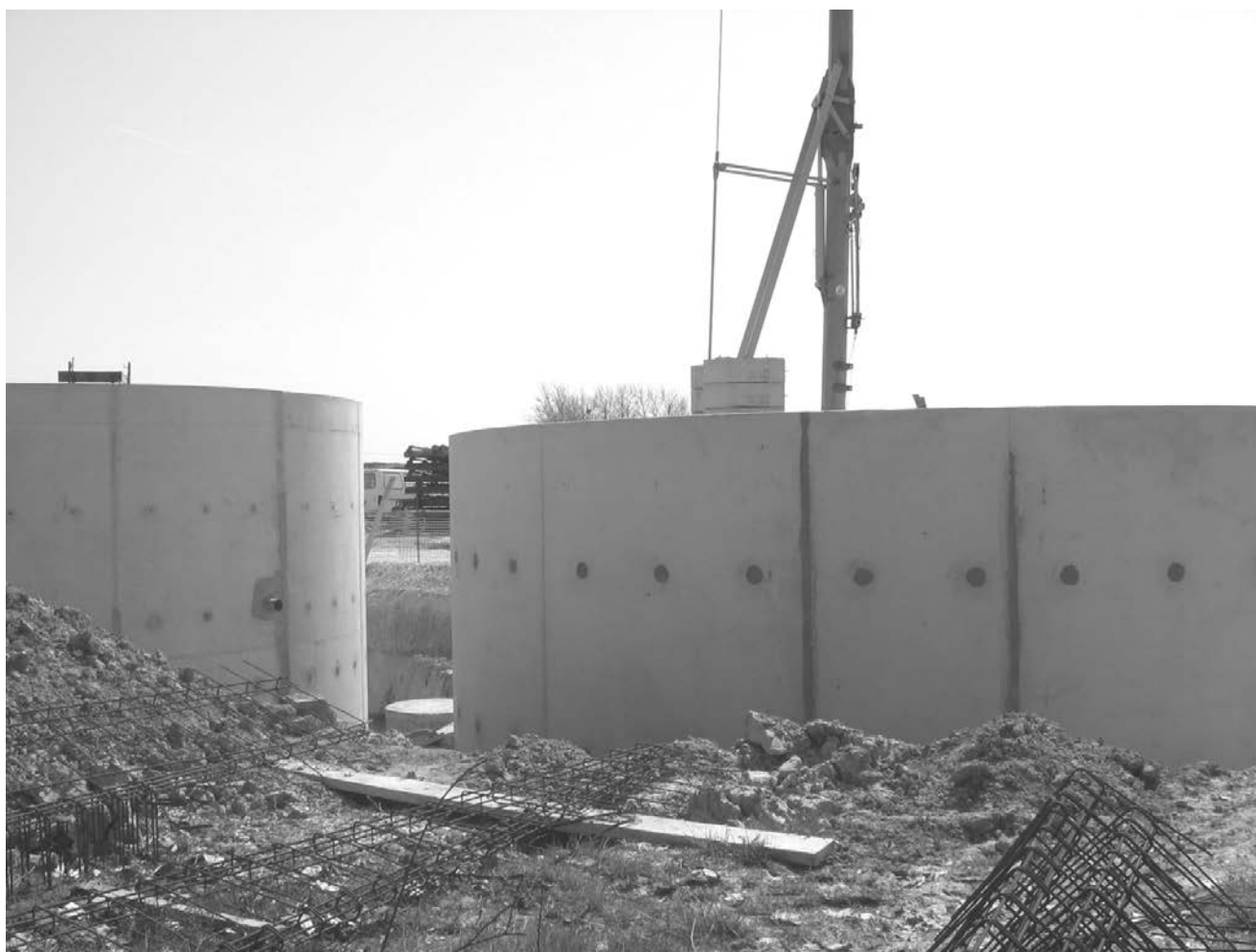
Construction de la nouvelle station d'épuration
